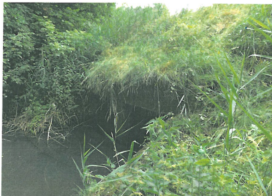
FOT 3 Ścianka czołowa - głowica wylotu (strona prawa) - wegetacja roślinności, zanieczyszczenie ziemią parapetów
