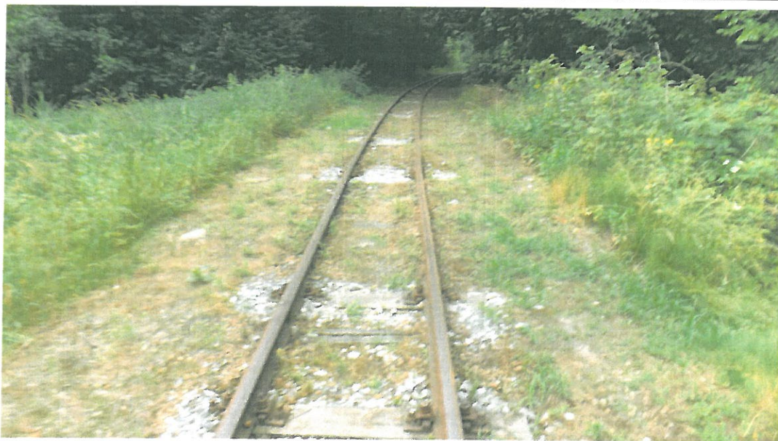
FOT 2 Ścianka czołowa - głowica wlotu (strona lewa) - wegetacja roślinności, zanieczyszczenie ziemią parapetów - spękania, ubytek betonu skrzydła
