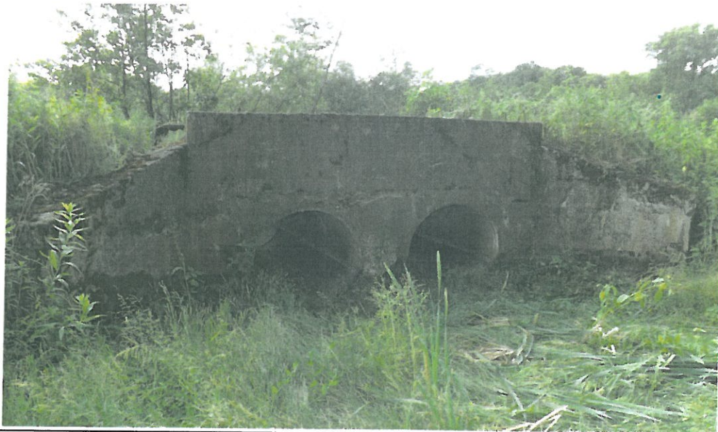
FOT 4 Ścianka czołowa - głowica wylotu (strona lewa)
