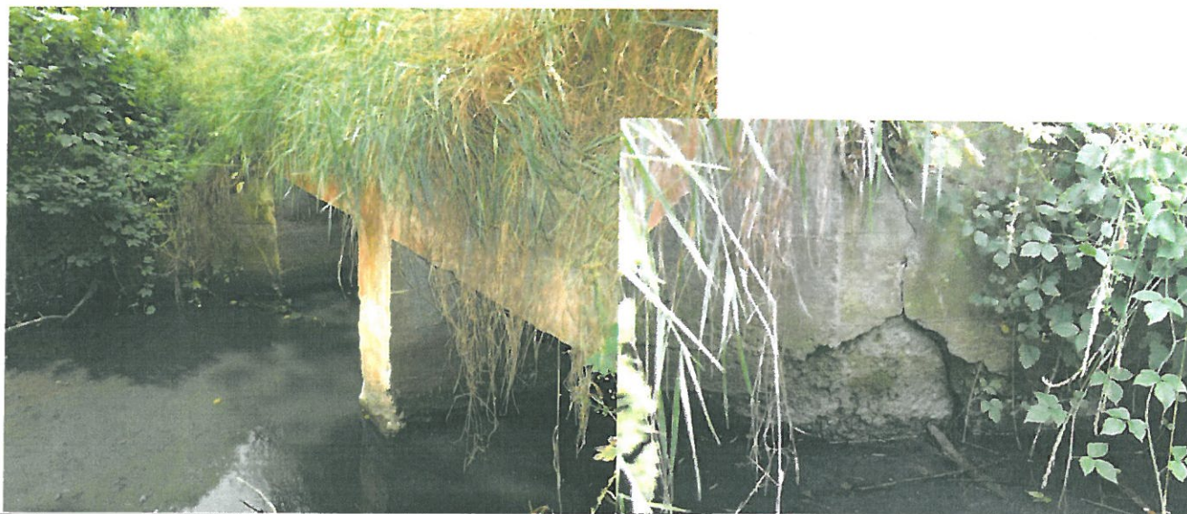
FOT 3 Ścianka czołowa - głowica wylotu (strona prawa) - wegetacja roślinności, zanieczyszczenie ziemią parapetów
