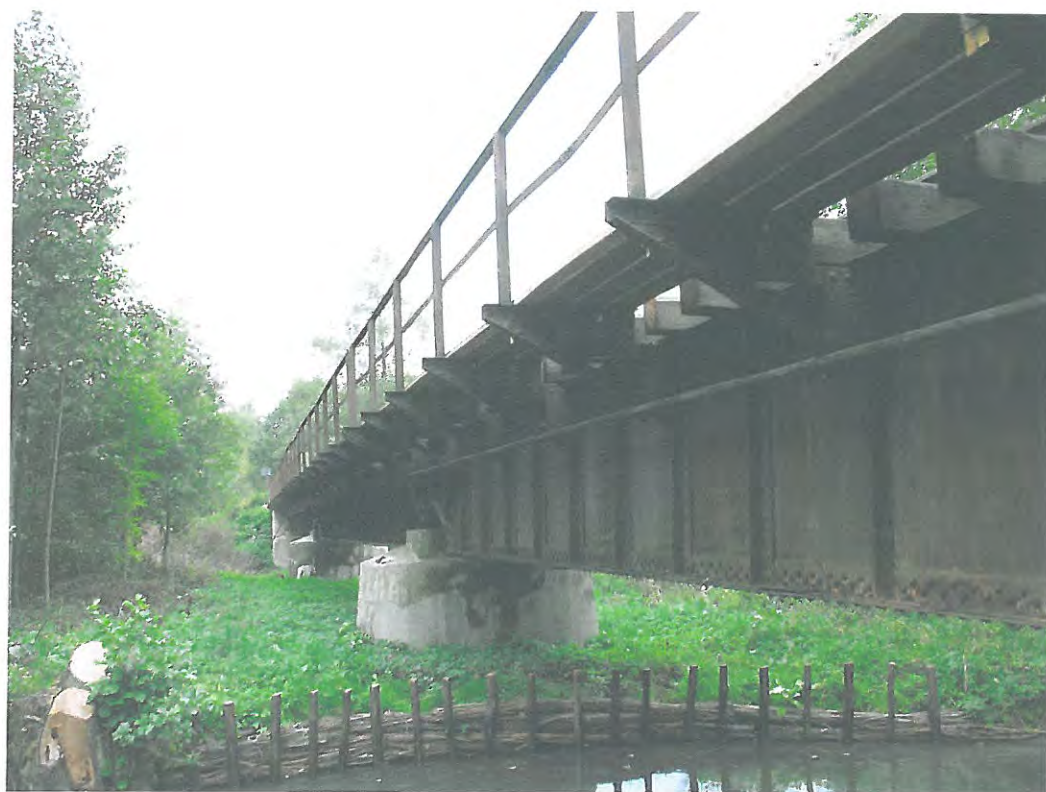
Fot. 1. Widok mostu z boku od strony dołu rzeki
