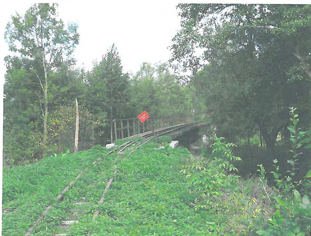
Fot. 2. Widok dojazdu do mostu od strony Opola Lubelskiego
