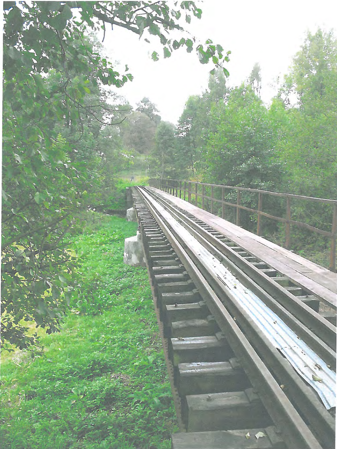
Fot. 3 Widok mostu z góry
