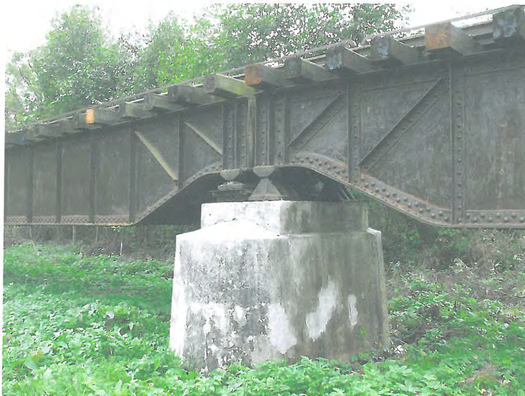
Fot. 4. Widok na jeden z filarów mostu
