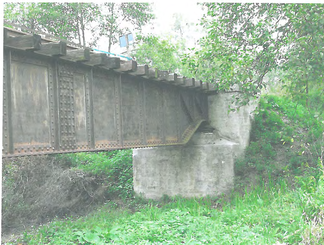
Fot. 5. Widok na przyczółek mostu od strony Nałęczowa
