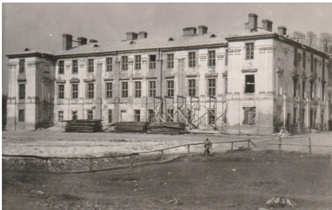
Fot. 1 Widok na elewację północną budynku, Lata 1947-1950, źródło: fotopolska.eu
