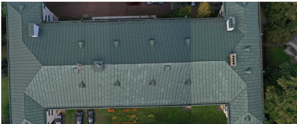
Fot. 5 Widok na dach budynku, źródło: fotografie własne
