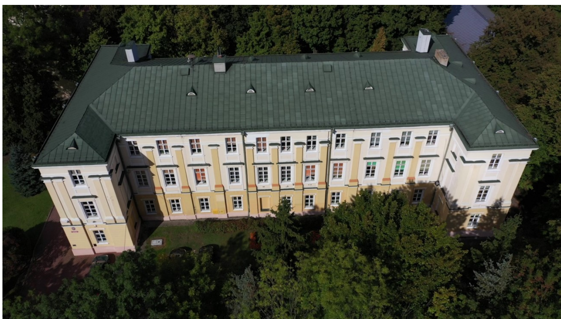
Fot. 4 Widok na dach budynku, źródło: fotografie własne
