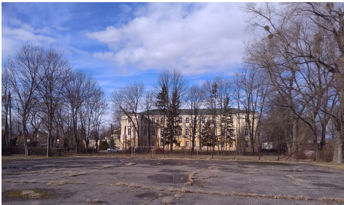
Fot. 3 Widok na elewację południową budynku, źródło: fotografie własne
