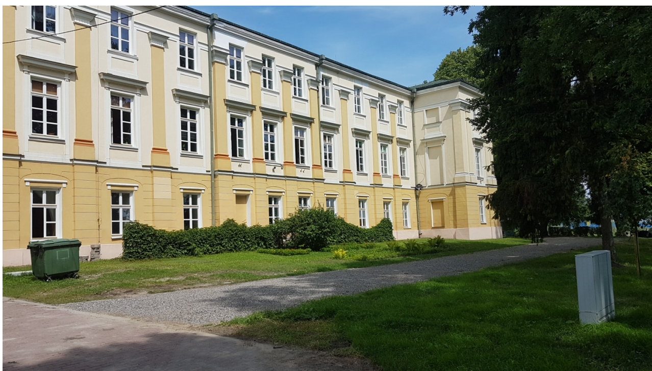
Fot. 2 Widok na elewację południową budynku, źródło: fotografie własne
