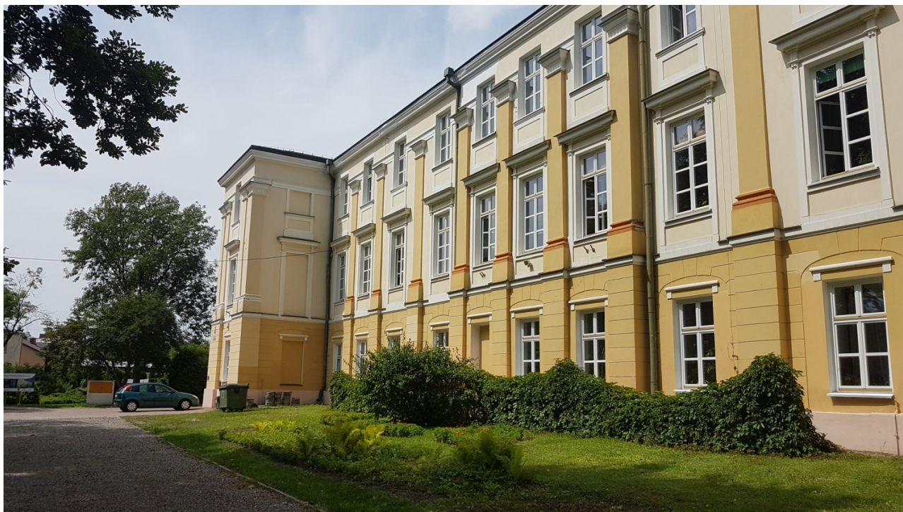
Fot. 1 Widok na elewację południową budynku, źródło: fotografie własne
