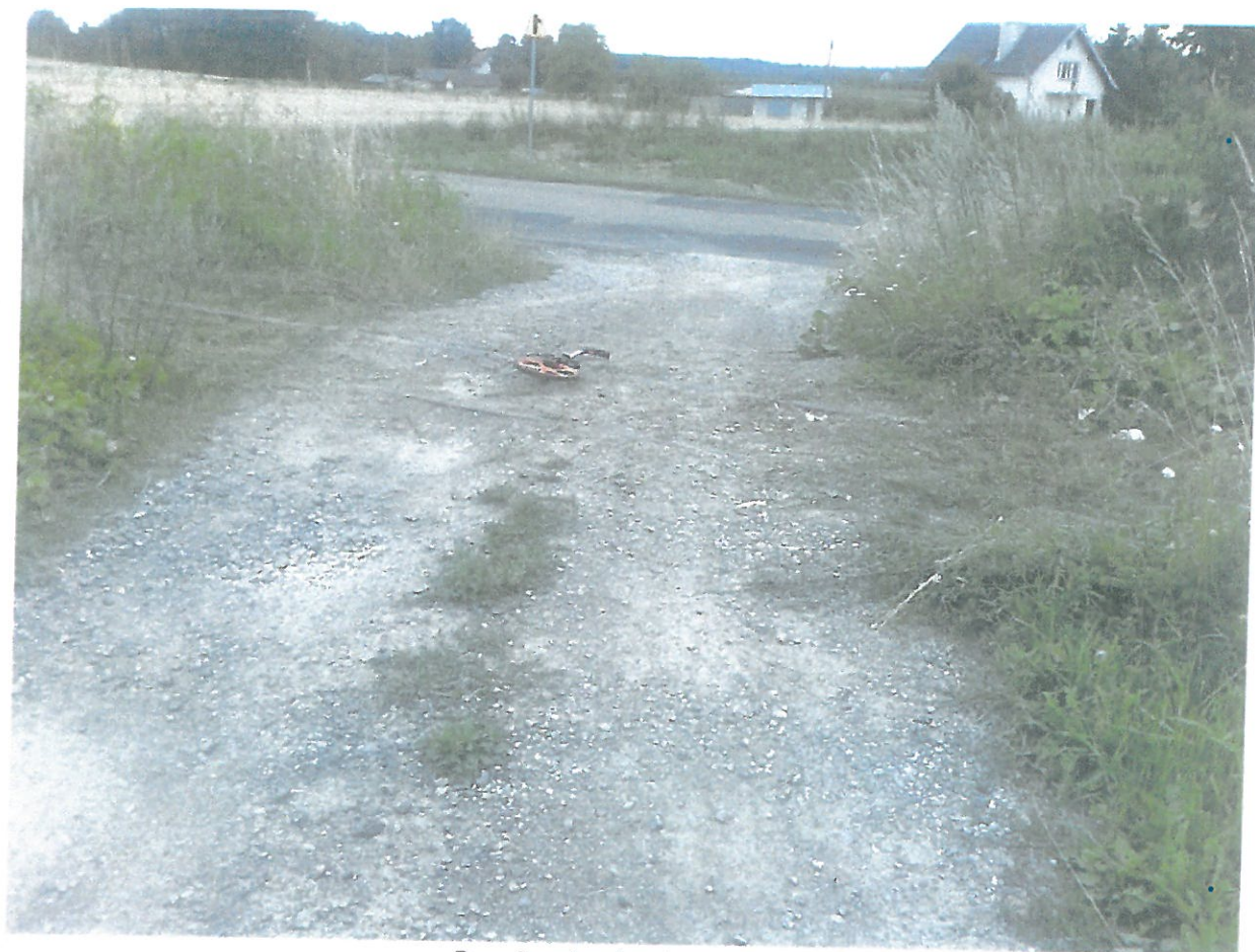
Rys. Przejazd w km 2.504
