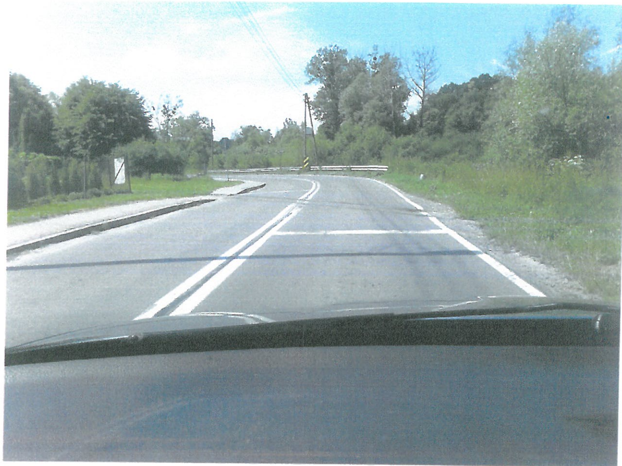
Rys. Przejazd w km 8.269
