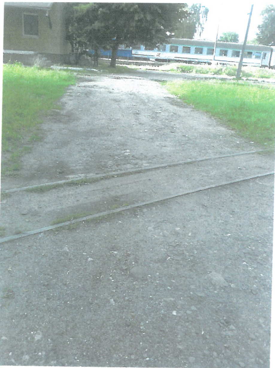
Rys. Przejazd w km 0.038 na łącznicy w Nałęczowie (między rozjazdami nr 2 i nr 5)
