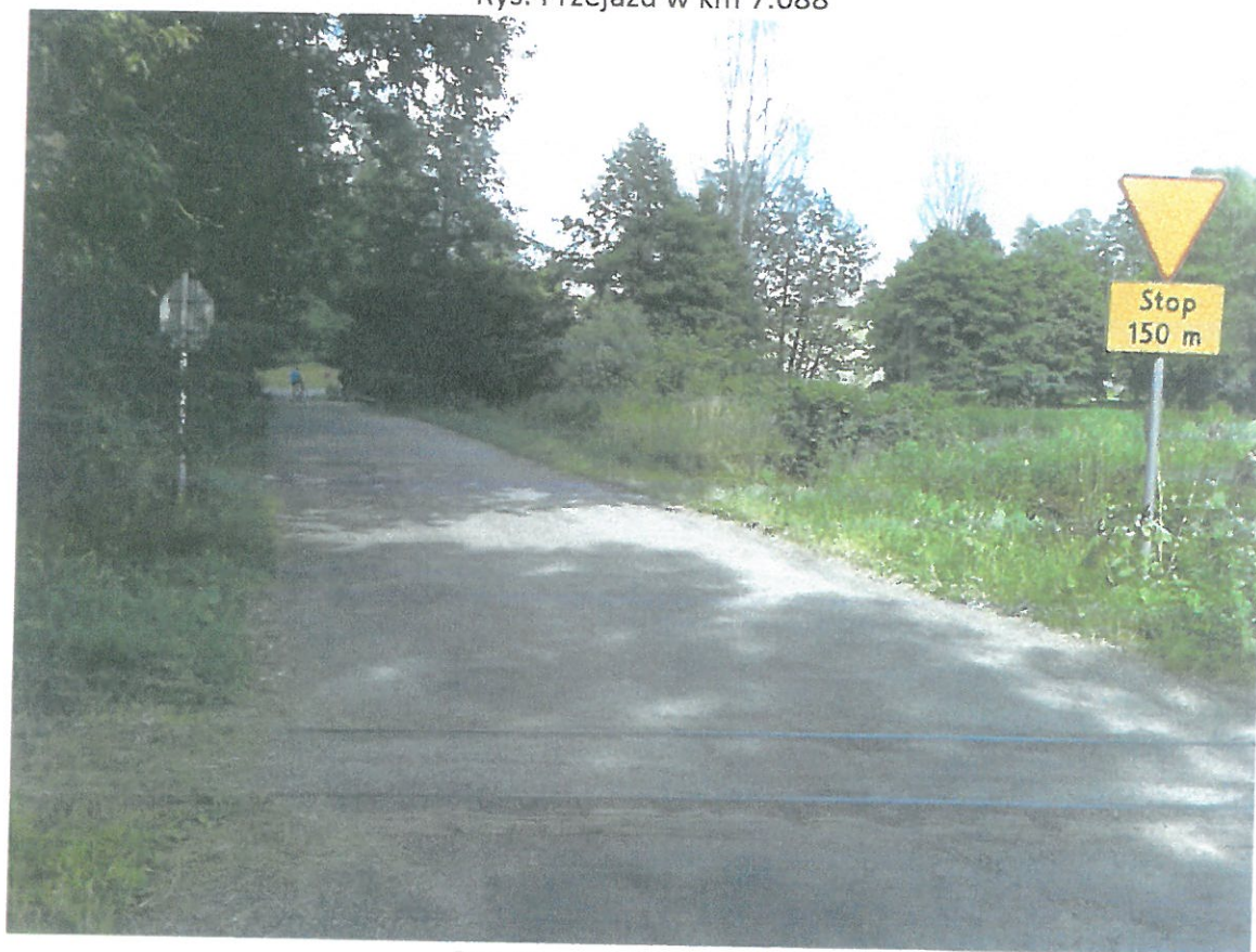
Rys. Przejazd w km 7.088
