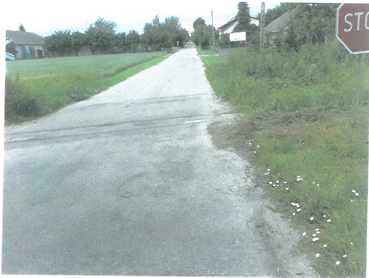
Rys. Przejazd w km 11.827
