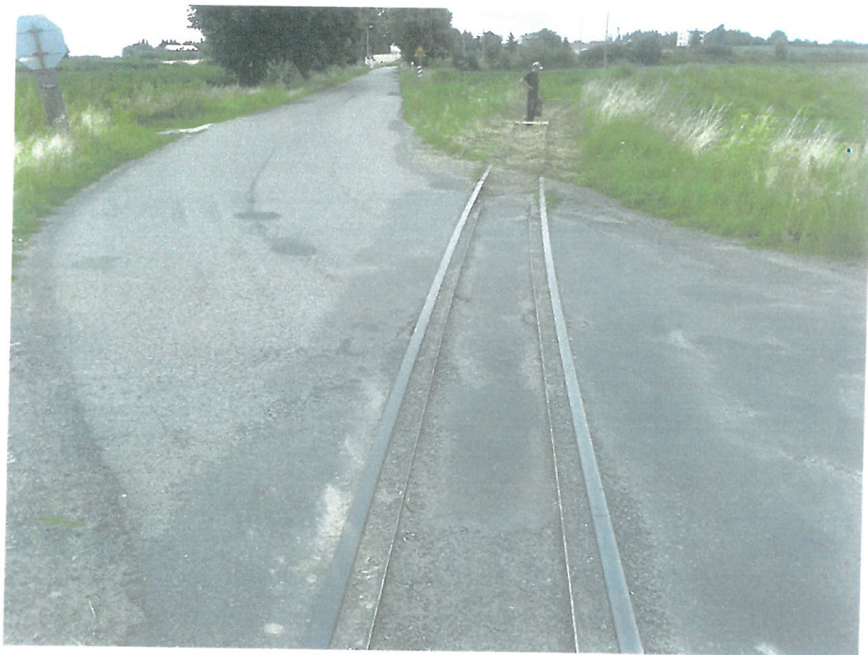
Rys. Przejazd w km 1.813
