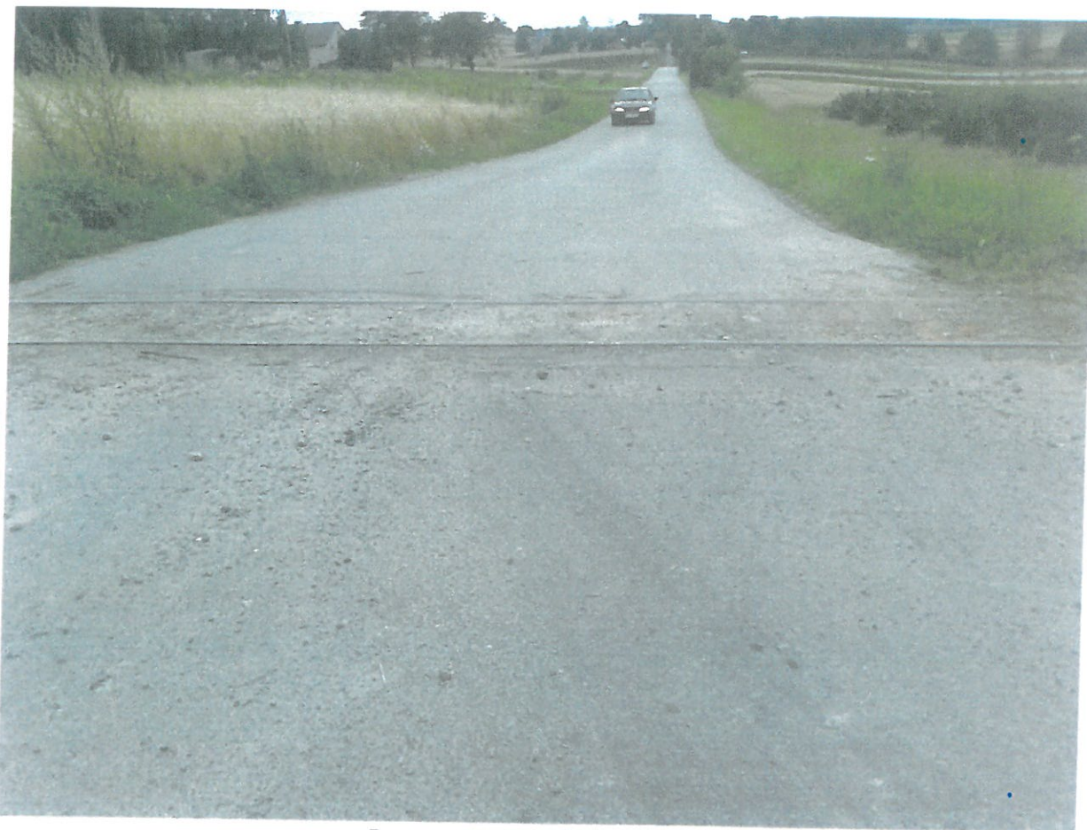
Rys. Przejazd w km 2.102
