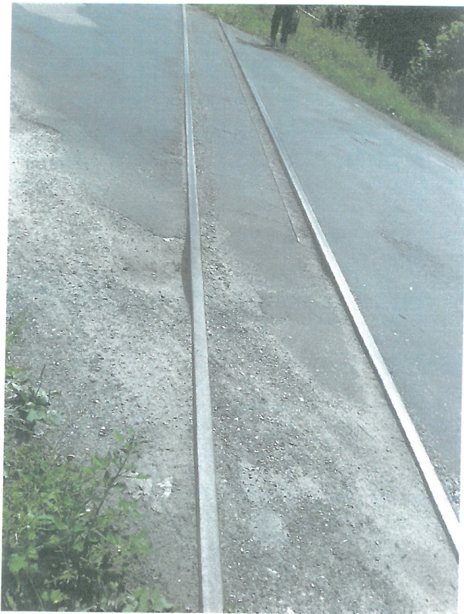
Rys. Przejazd w km 9.417
