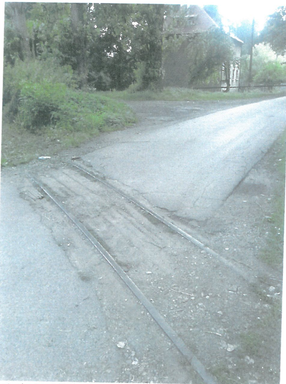
Rys. Przejazd w km 0.058 na łącznicy w Nałęczowie (między rozjazdami nr 2 i nr 5)
