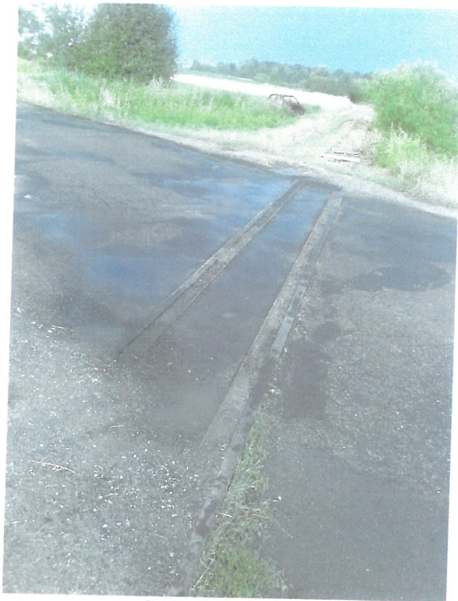
Rys. Przejazd w km 4.208
