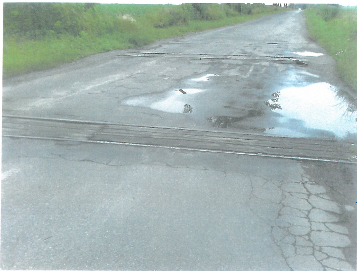
Rys. Przejazd w km 12.938
