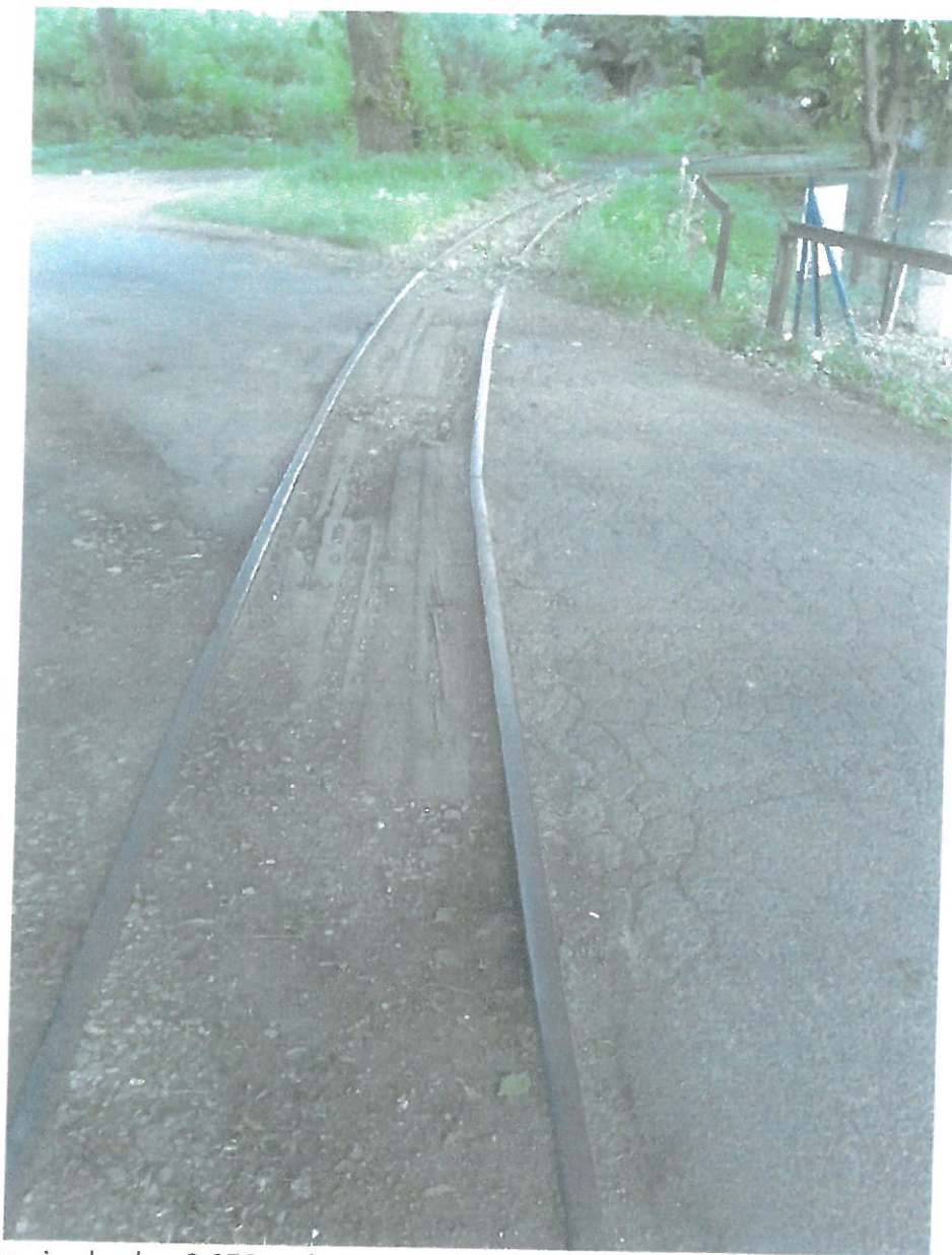
Rys. Przejazd w km 0.058 na łącznicy w Nałęczowie (między rozjazdami nr 5 i nr 3)
