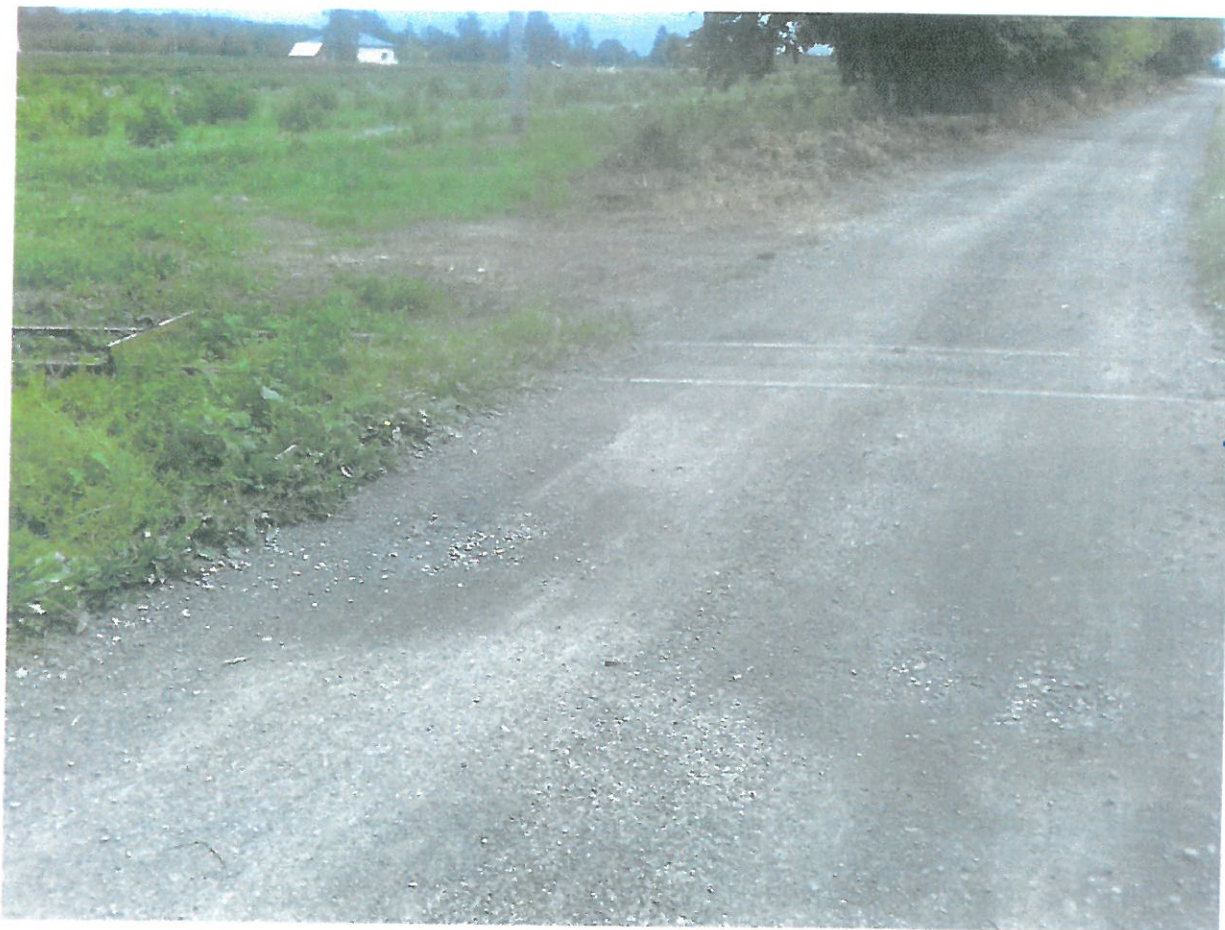
Rys. Przejazd w km 12.432
