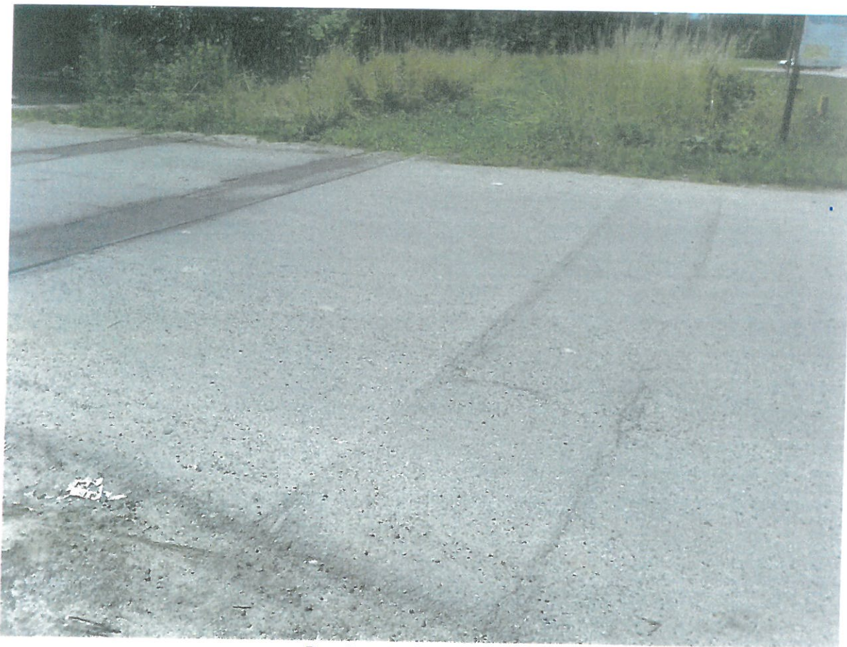
Rys. Przejazd w km 7.996
