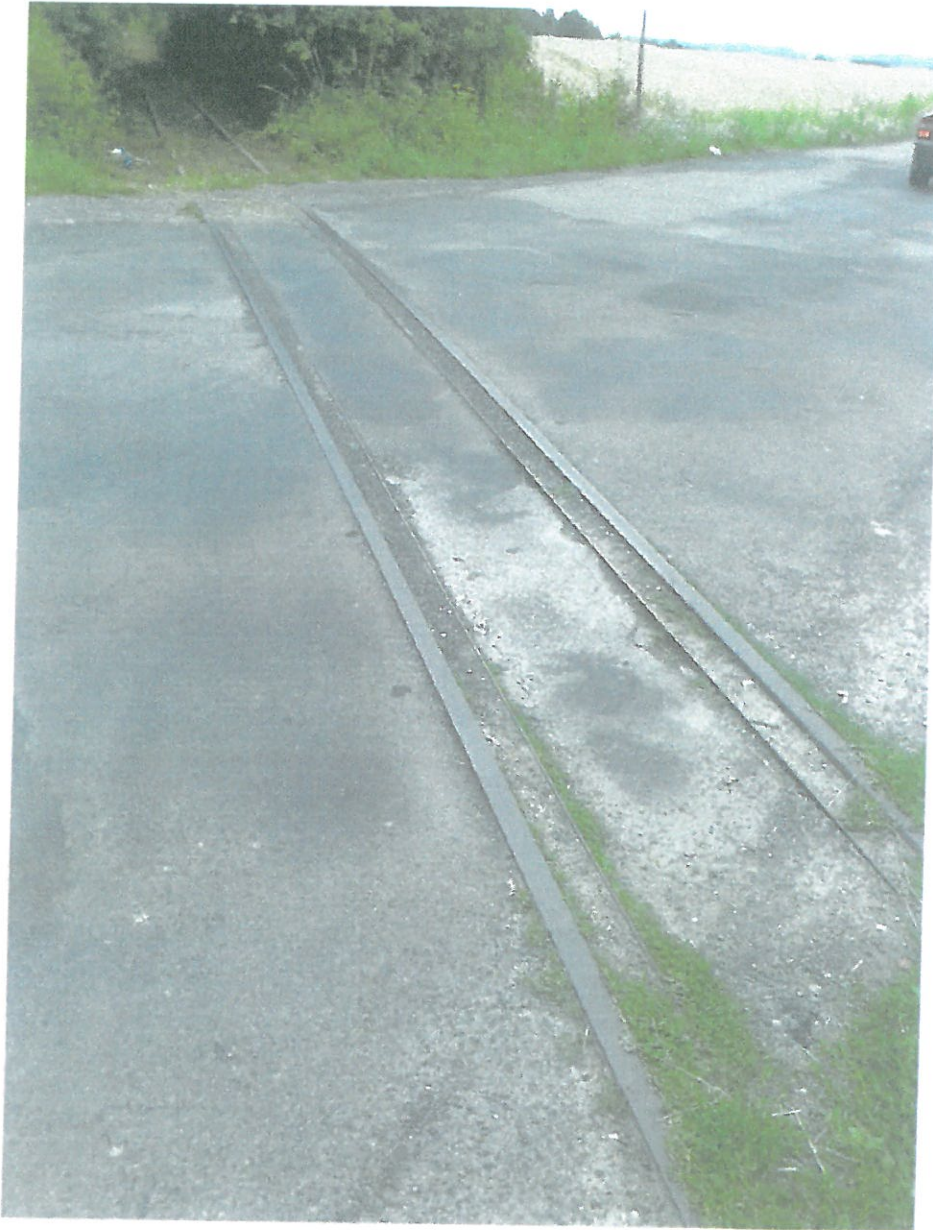
Rys. Przejazd w km 3.062
