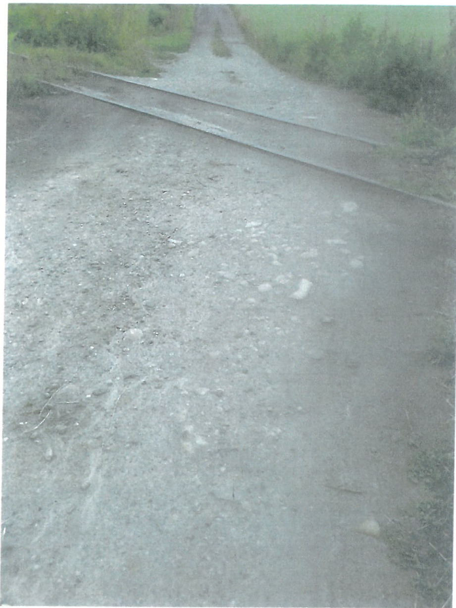
Rys. Przejazd w km 13.218 na szlaku Wymysłów – Niezabitów
