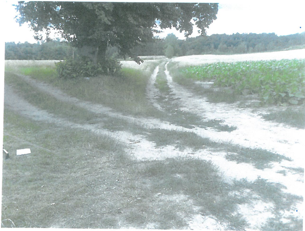
Rys. Przejazd w km 5.534
