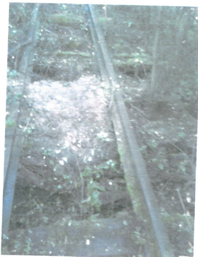
Rys. Wyrwa na długości 5m w km 4.095(nieprzytwierdzony tor)
