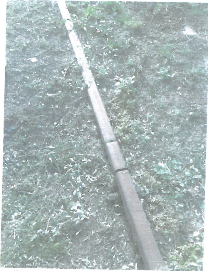
Rys. Wstawiona ciętka w złączu klasycznym w km 1.265
