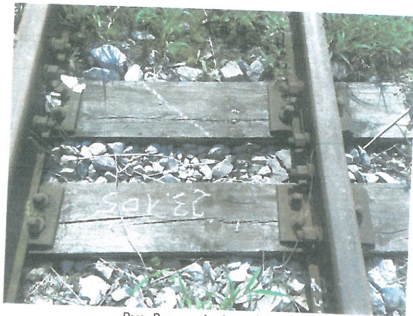
Rys. Przesunięcie styków
