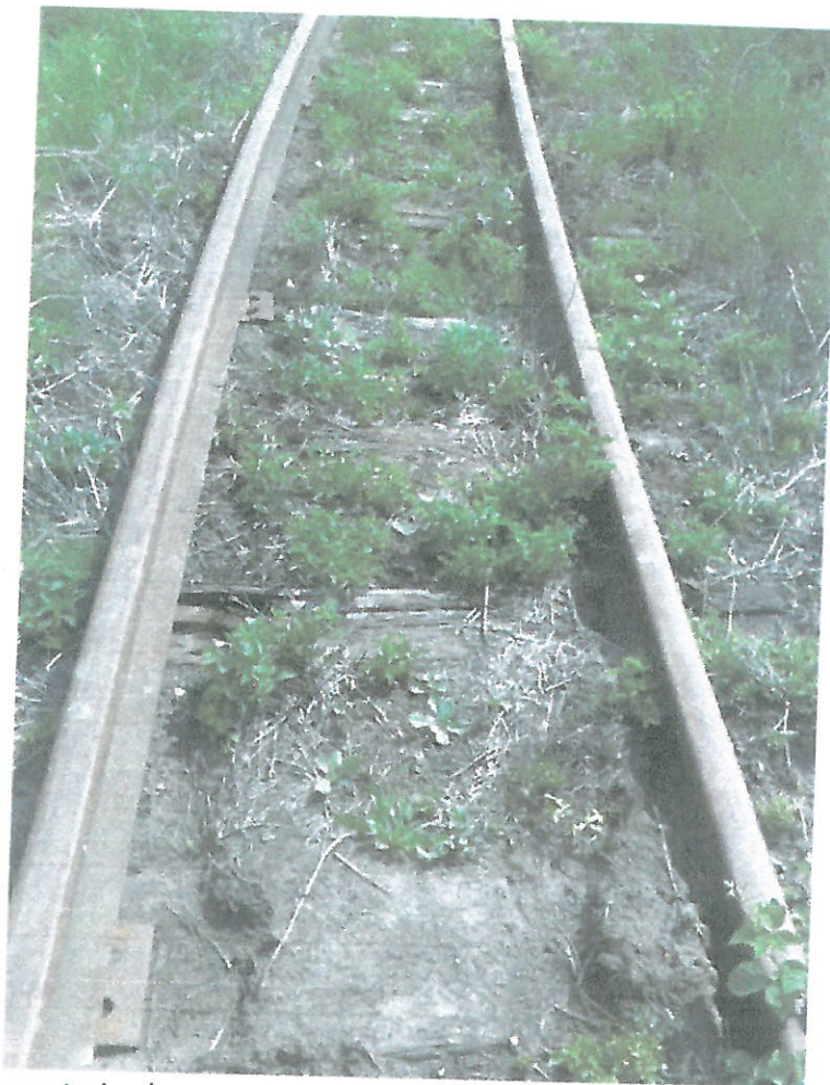
Rys. Nieprzytwierdzony tor na łuku w km 16.580 (poszerzenie do 57mm)
