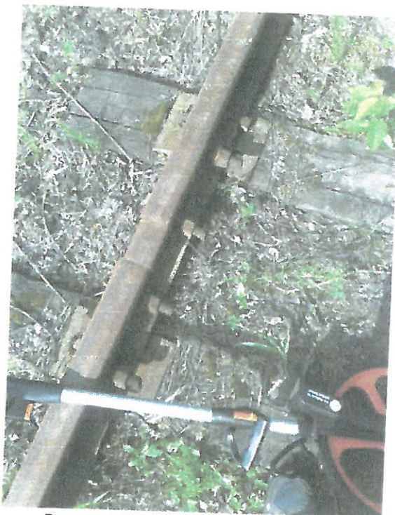
Rys. Ciętka na złączu klasycznym
