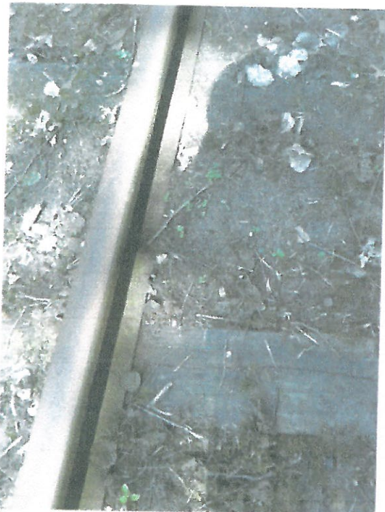
Rys. Bezpośrednie przytwierdzenie szyny hakiem
