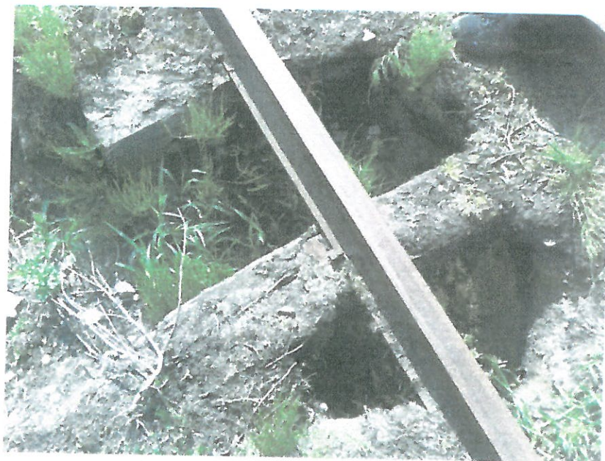
Rys. Wyrwa w podtorzu
