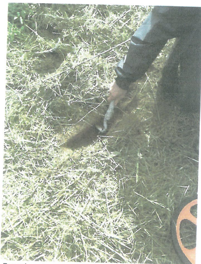
Rys. Zamulony teren na głębokość 20cm w km 5.350 – 4.950
