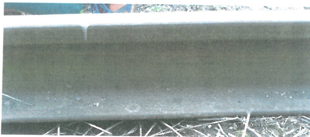
Rys. Szyna typu S41
