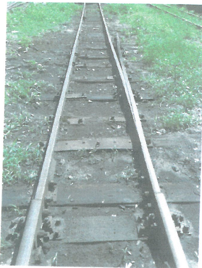
Rys. Rozebrany rozjazd nr 4
