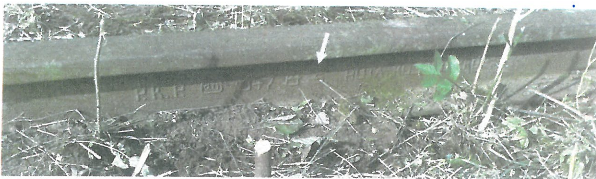
Rys. Szyna typu S41
