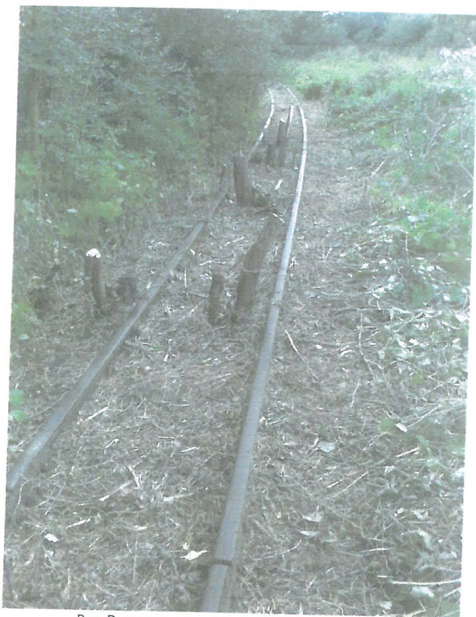
Rys. Drzewa porastające środek toru w km 5.365
