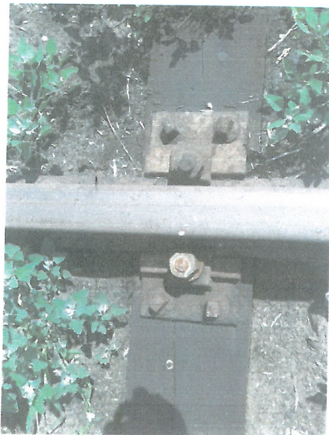
Rys. Przytwierdzenie typu K na łukach
