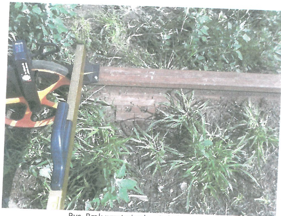
Rys. Brak przytwierdzenia hakowego
