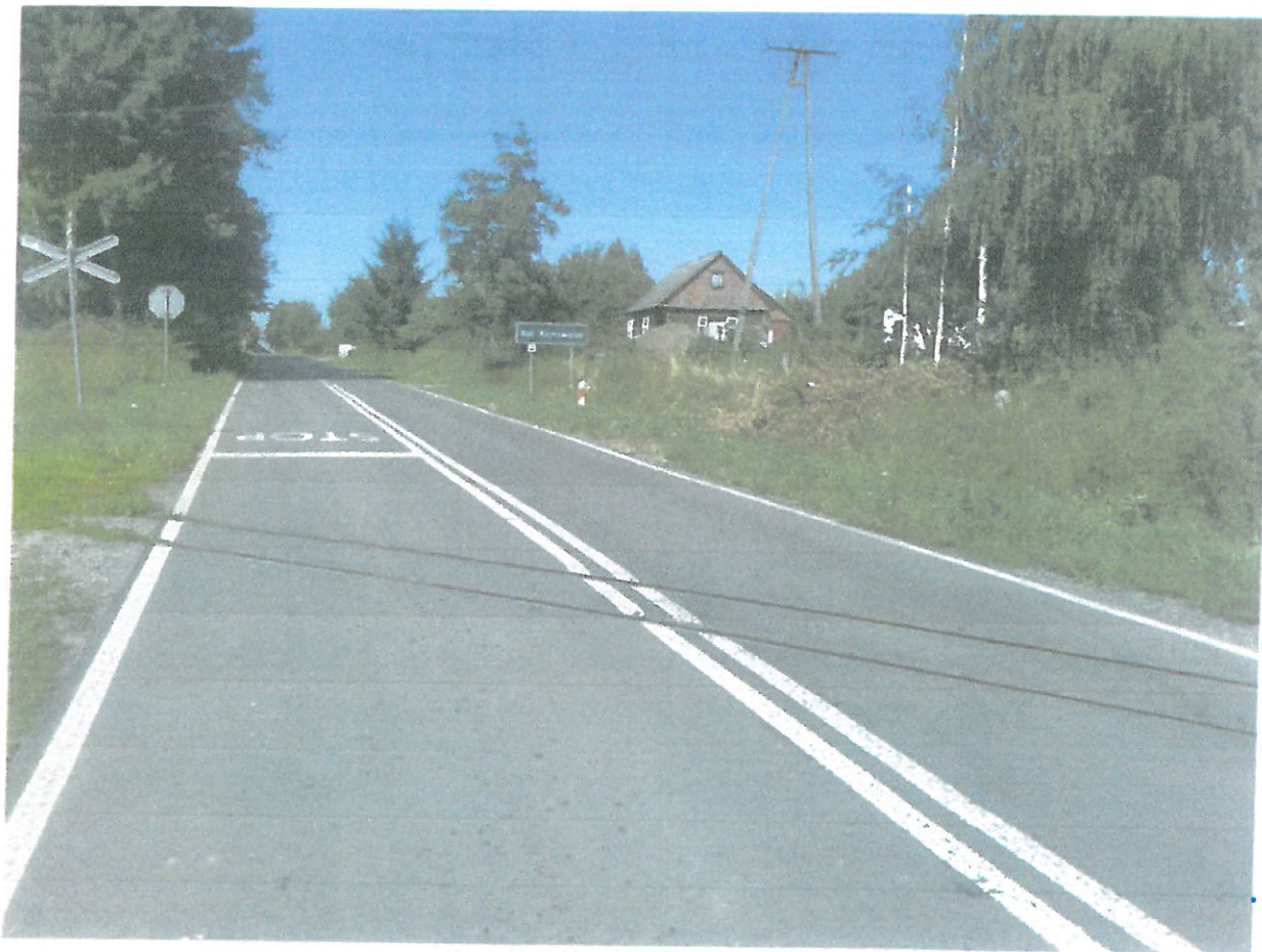
Rys. Przejazd w km 18.310
