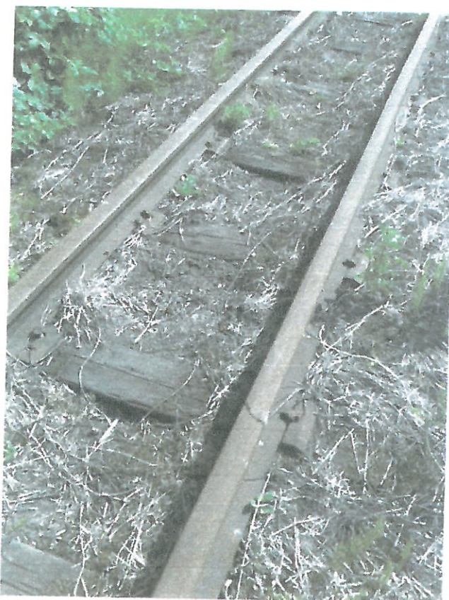
Rys. Przytwierdzenie hakowe
