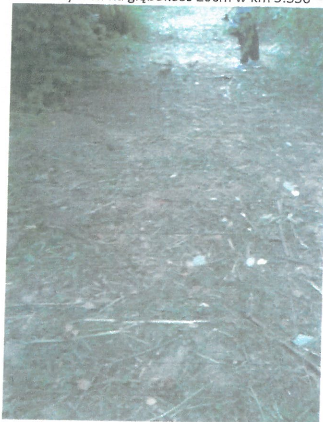
Rys. Zamulony tren na głębokość 20cm w km 5.350 – 4.950
